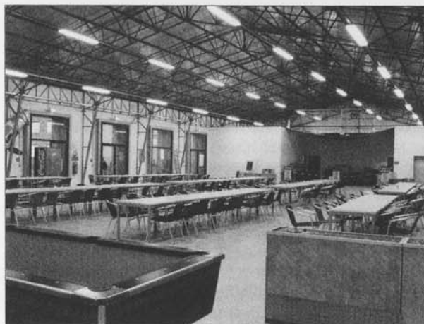
Die ehemalige Turnhalle im Jahr 1995... ... hergerichtet zum Mehrzweckgebäude im Jahr 2007. Fotos: Archiv DenkMAL-Prora e.V.
